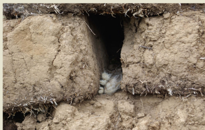
売られた家畜の毛(ヤン)が大切に保管される土壁の隙間
